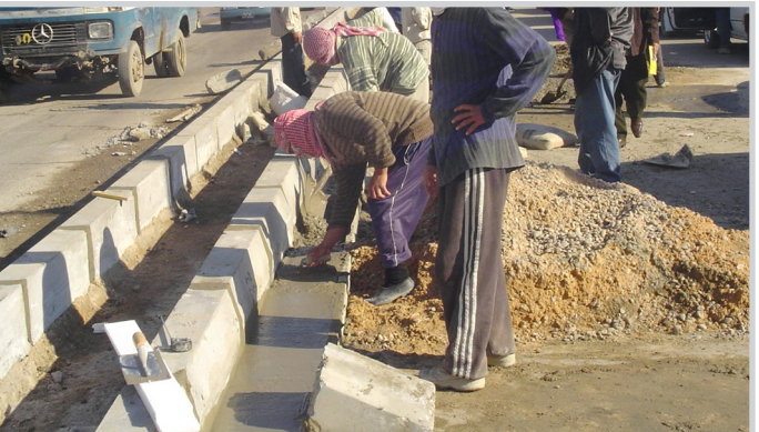
مشروع اعمار الطرق
