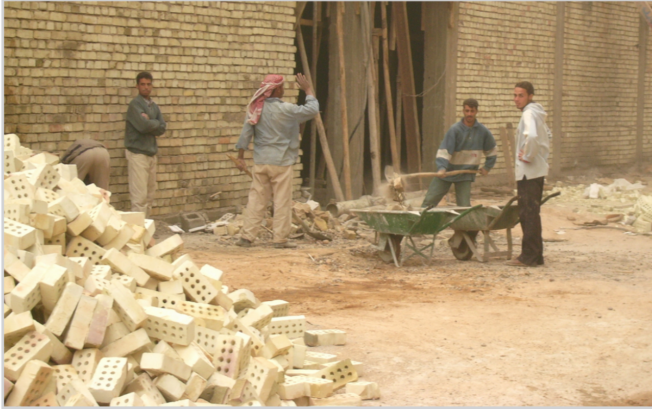
موقع بناء أحد المشاريع
