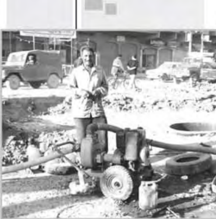
الله يكون في العون لعرفة أسباب هذه الانسدادات في المجاري زرننا عدداً من محطات المجاري في بغداد... وقد عزز اغلب العاملين فيها ذلك الى مجموعة من الشكايات... فمن العلوم ان قطر الانابيب المثقلة بتمزيد استءاء من شبكات مجاري البيوت الى المجاري المثقلة تنصب هذه في المجاري الحرة والبيع مسجدا الاطفال يلعبون بجوار البرك الطويلة للمياه الآسنة، ان لم يجدهم يخوضون فيها، كما ان عدداً من المواطنين لجأ الى بيع منزله والانتقال الى مناطق أخرى بسبب اليباس من حمل هذه الشكلة.
