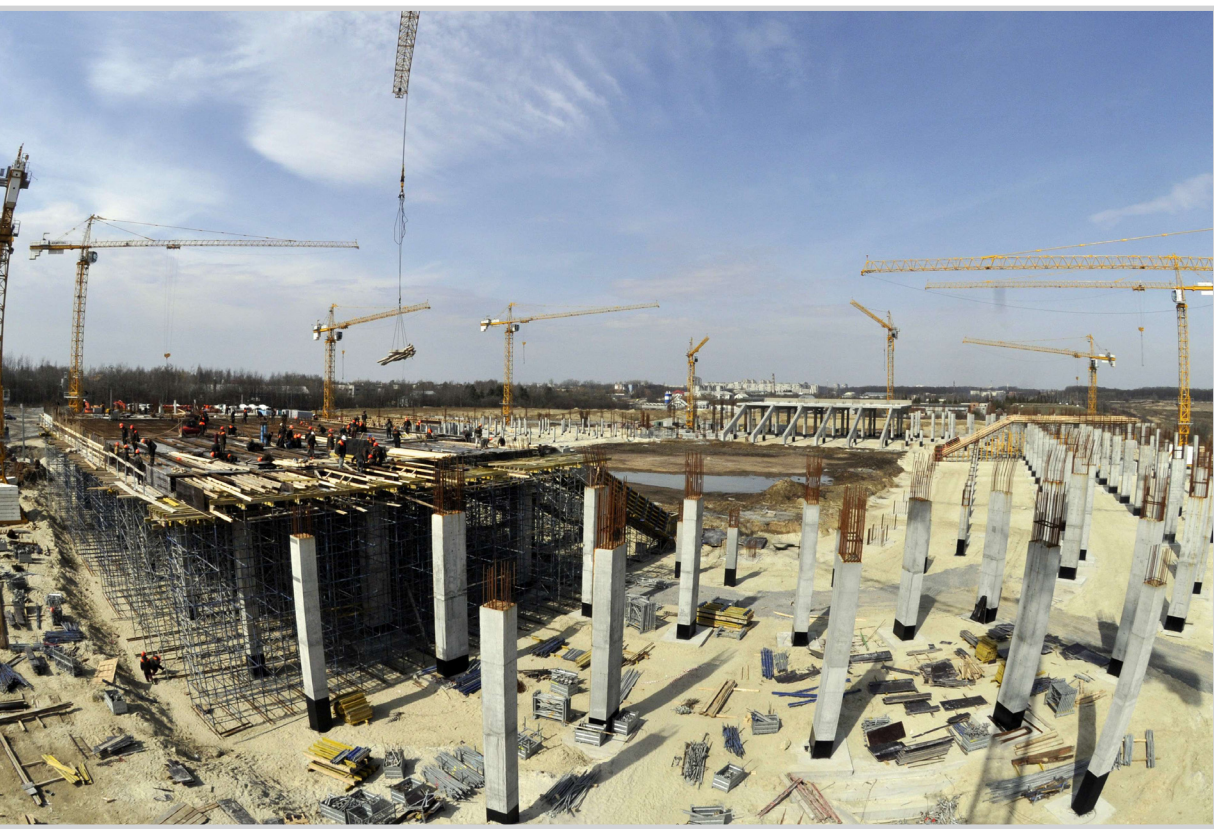
مشروع قيد الانشاء
