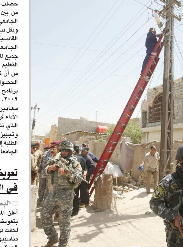
رفع التجاوزات عن الشبكة الكهربائية
