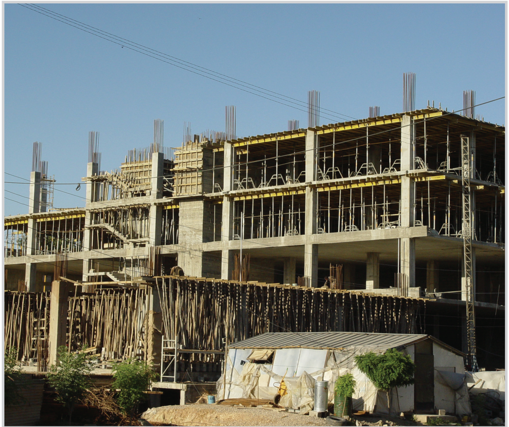
شقق سكنية قيد الانشاء
