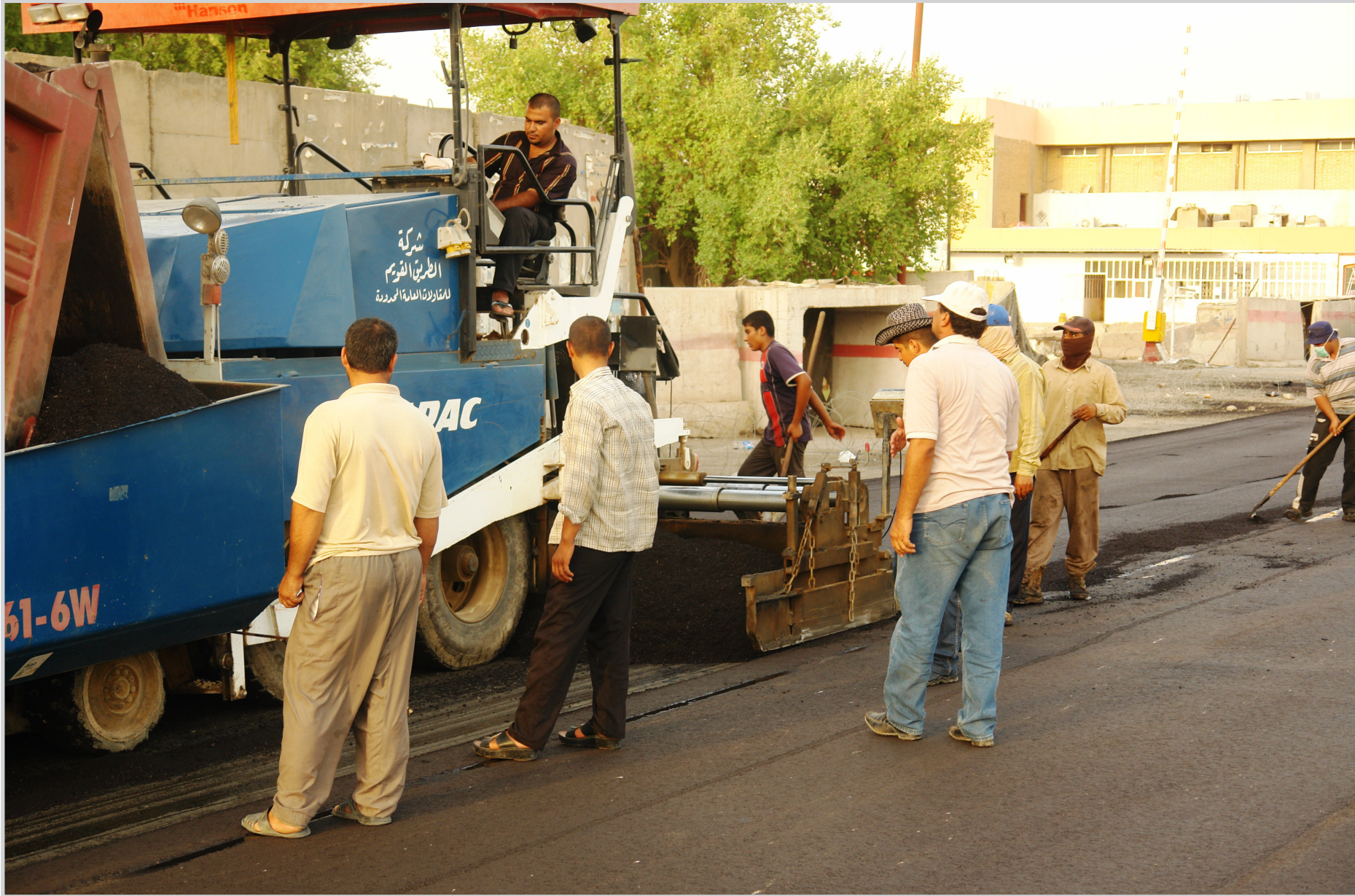
من أعمال أكساء الطرق... تصوير: ادم يوسف
