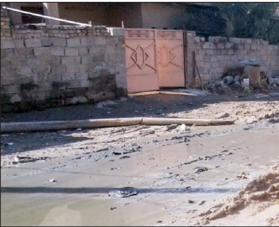
مياه المجاري تملأ الشارع
