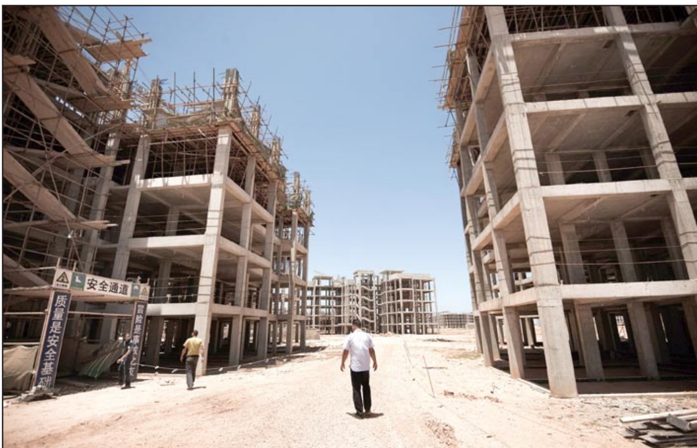
مجمع سكني قيد الانشاء (أرشيف)
