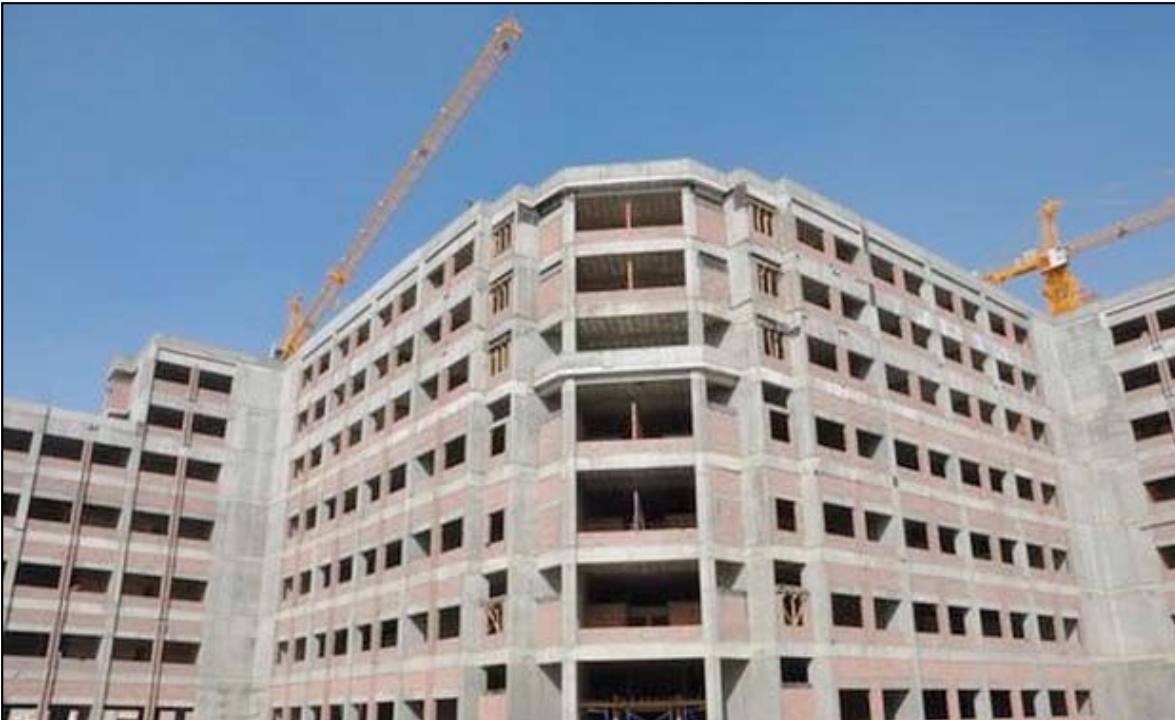
مشاريع استثمارية قيد الانشاء
