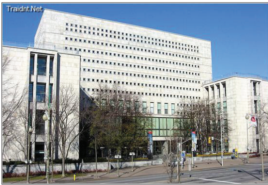
٤- المكتبة الوطنية الكندية (National Library of Canada) المكتبة الوطنية الكندية هي من ضمن أشهر التشييدات الحديثة في العالم، تقع في مدينة أوتاوا في كندا وقد تم بناؤها عام ١٩٥٣ ويبلغ عدد الكتب التي توجد في هذه المكتبة ١٨,٨٠٠ مليون كتاب
