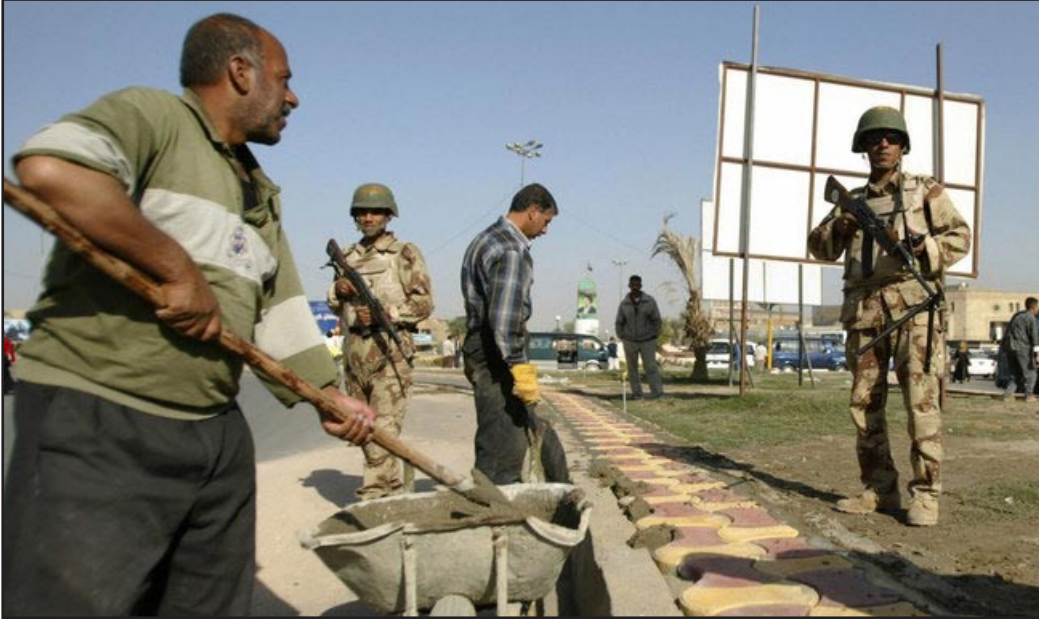
عمال يقومون برصف إحدى طرق.. ( ارشيف)
