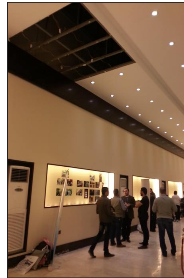
لمحة توضع انهيار جزء السقف الثانوي لاحدى قاعات المعرض فيما يظهر في الصورة الثانية تحطم زجاج احد العارضات .. (خاص بالمدى)
