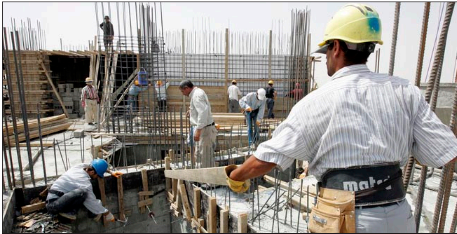
لحد مشاريع البنى التحتية ( ارشيف)
