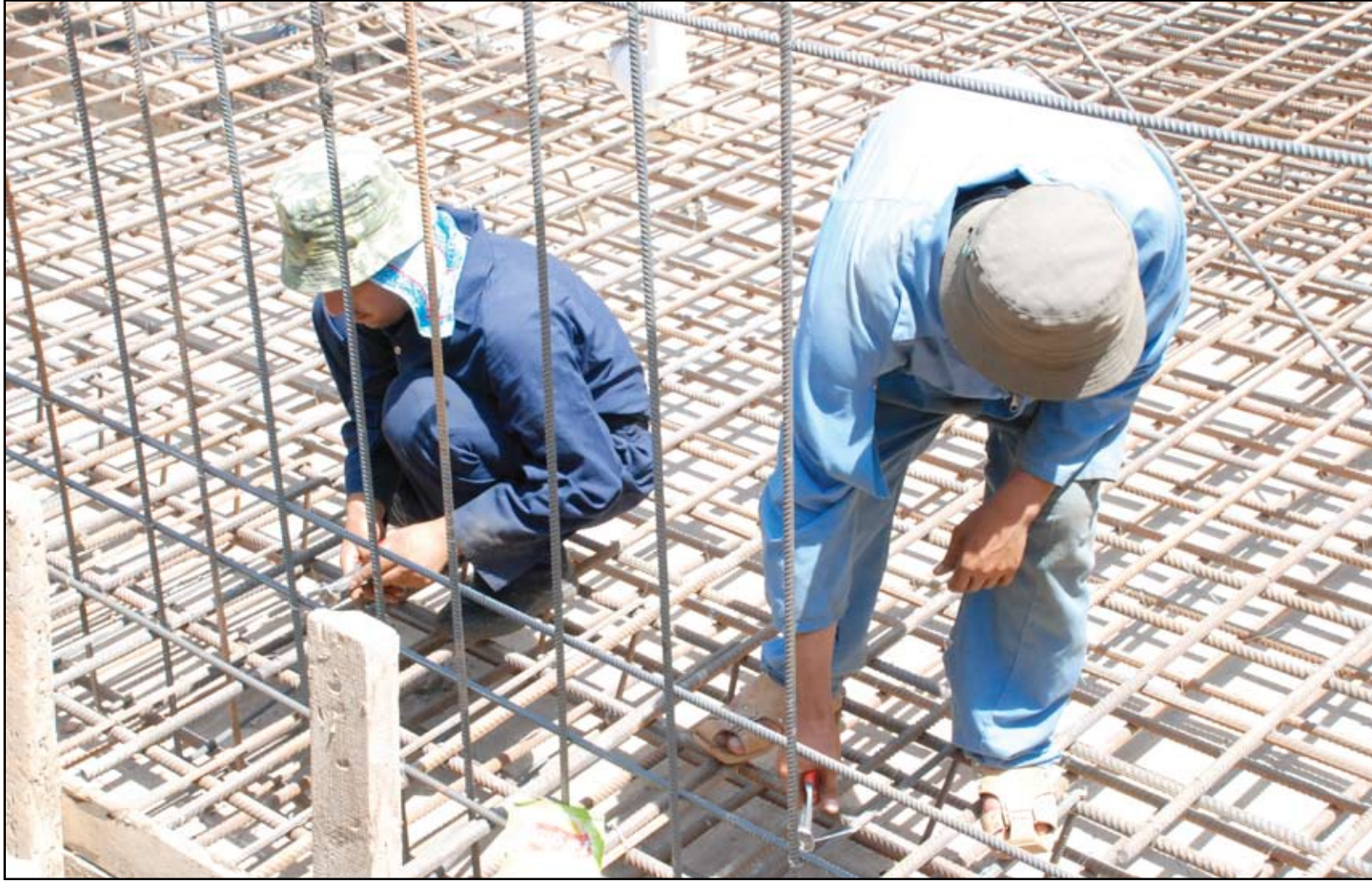
لحد مشاريع البنى التحتية
