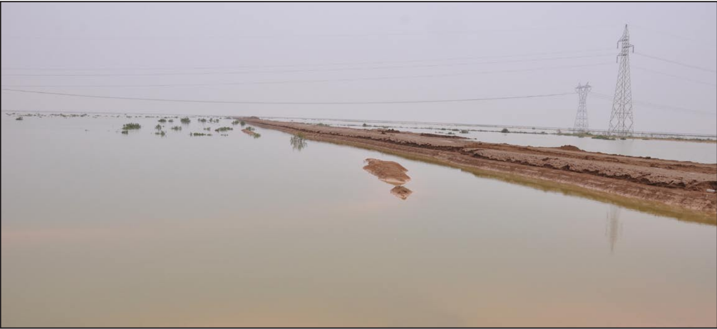
السدة الوترية جنوب شرق ناحية شيخ سعد قبل انهيارها جراء السيول القادمة من إيران
