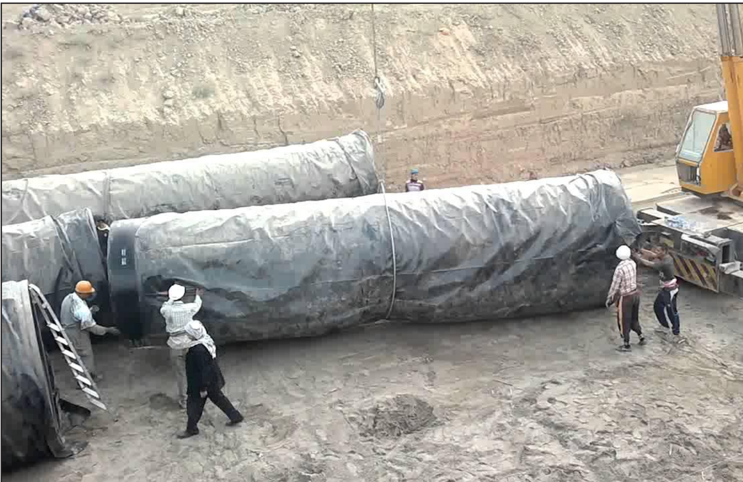
عملية ربط الانابيب في مشروع ماء الرصاف ببغداد
