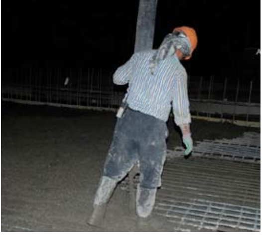
مراحل صب الاسس في مستشفى الكوت التعليمي المنفذ من قبل إحدى الشركات التركية
