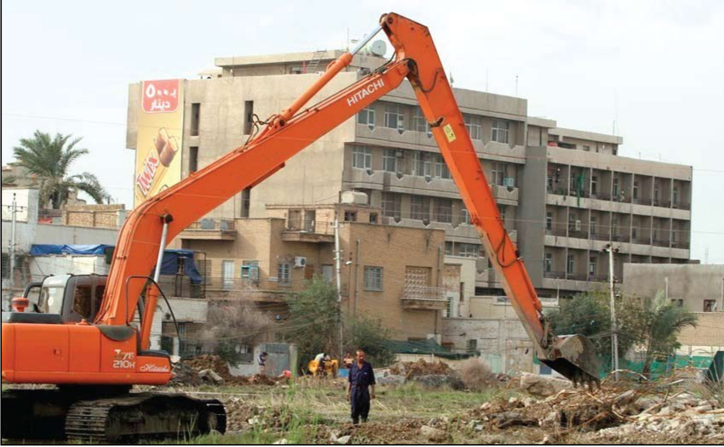
أعمال صيانة وتأهيل منطقة بارك السعدون وسط بغداد
