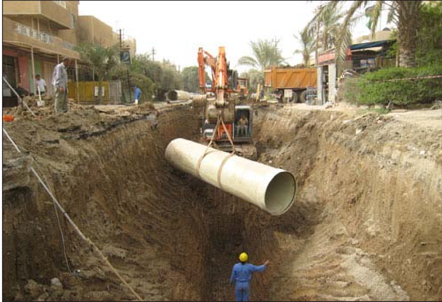
جانب من اعمال تشييد خط القدس للمجاري
