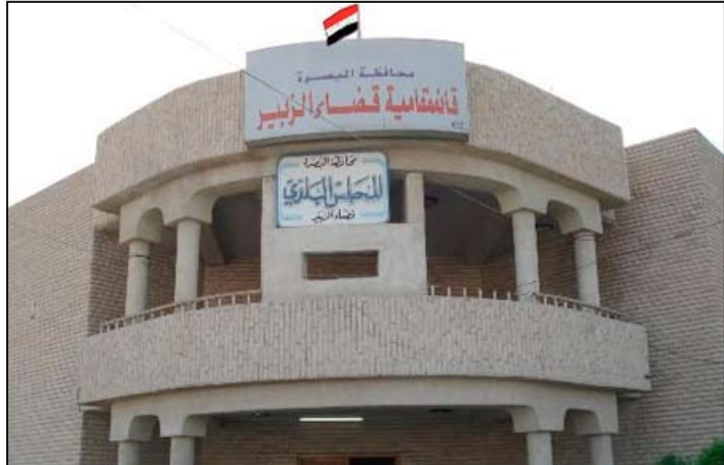
مبنى قائممقامية الزبير - ارشيف
