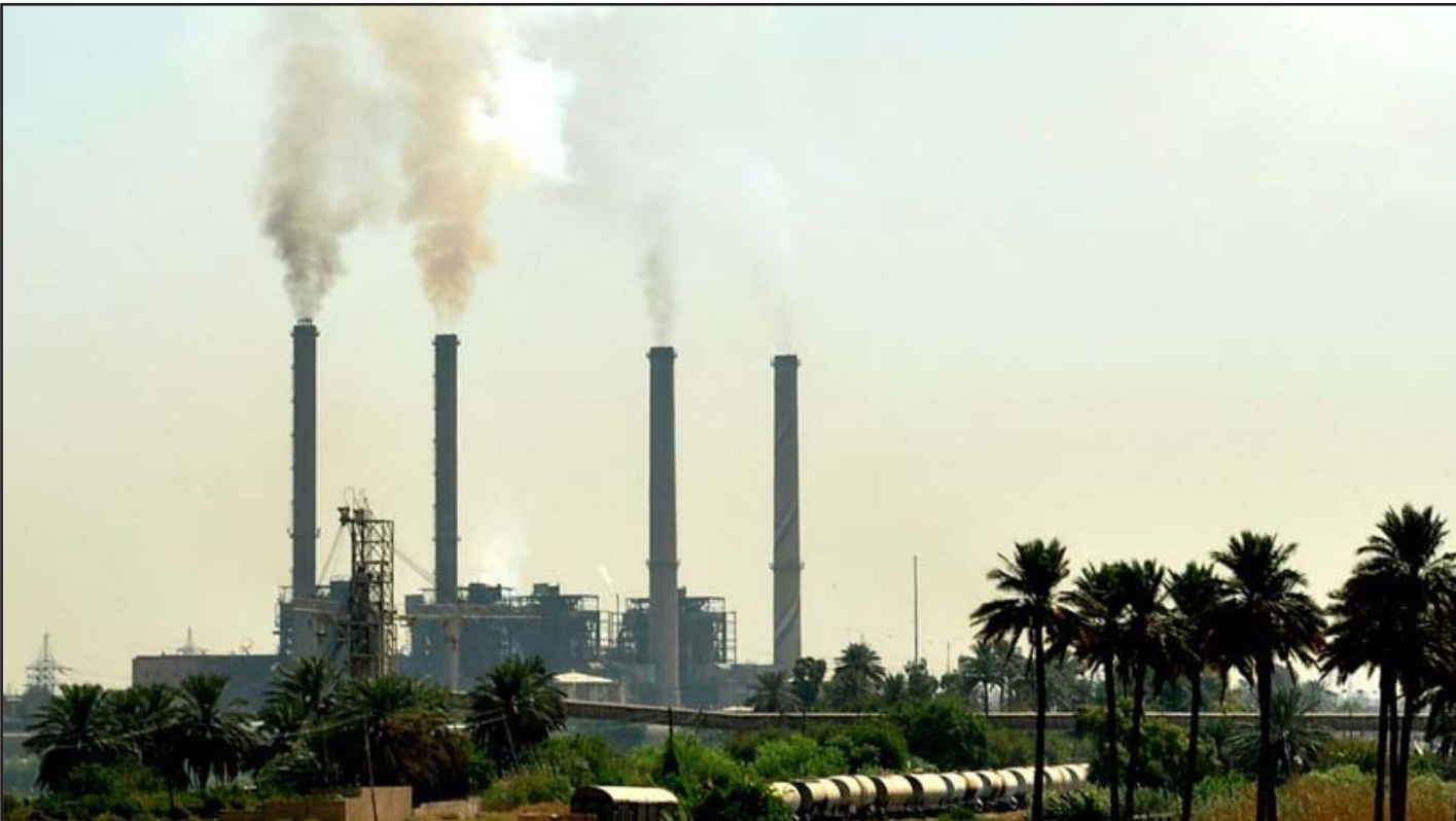
محطة كهرباء الدورة جنوبي بغداد
