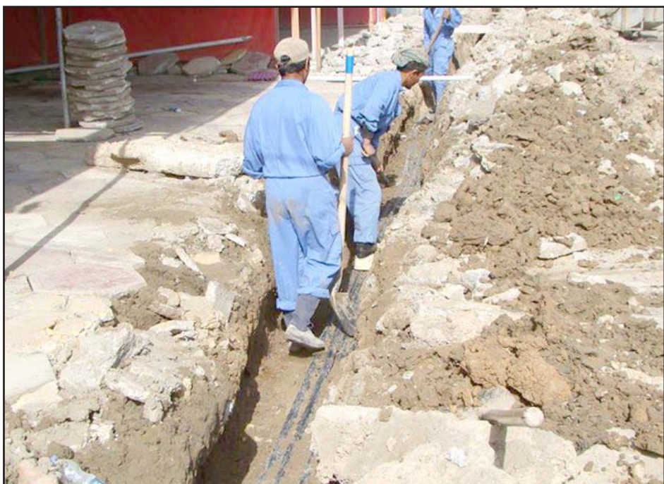
عمال الاتصالات يمدون كبل ضوئي للإنترنت.. أرشيف
