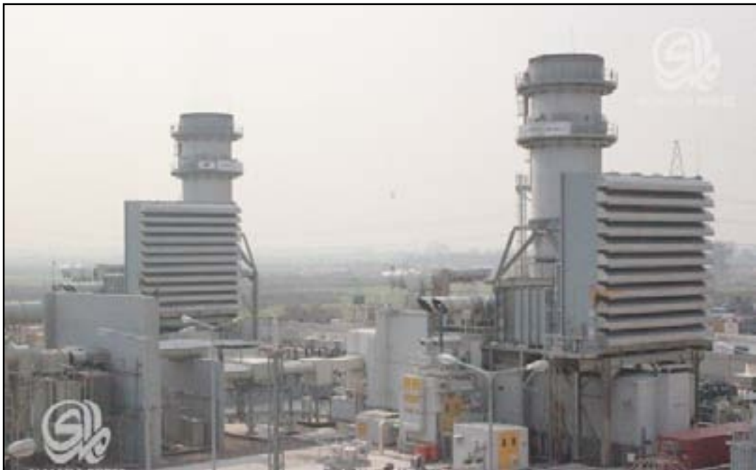
محطة كهرباء القدس الحاررية شمال بغداد
