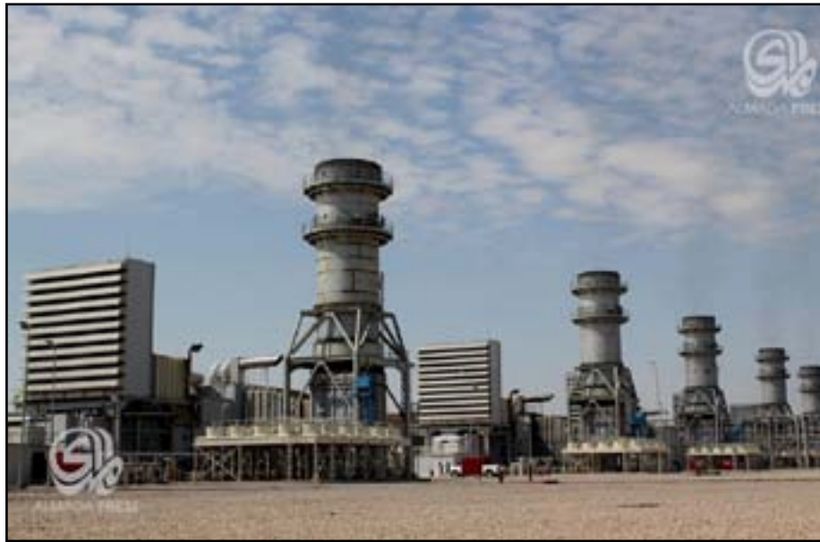
محطة كهرباء الخيرات في محافظة كربلاء
