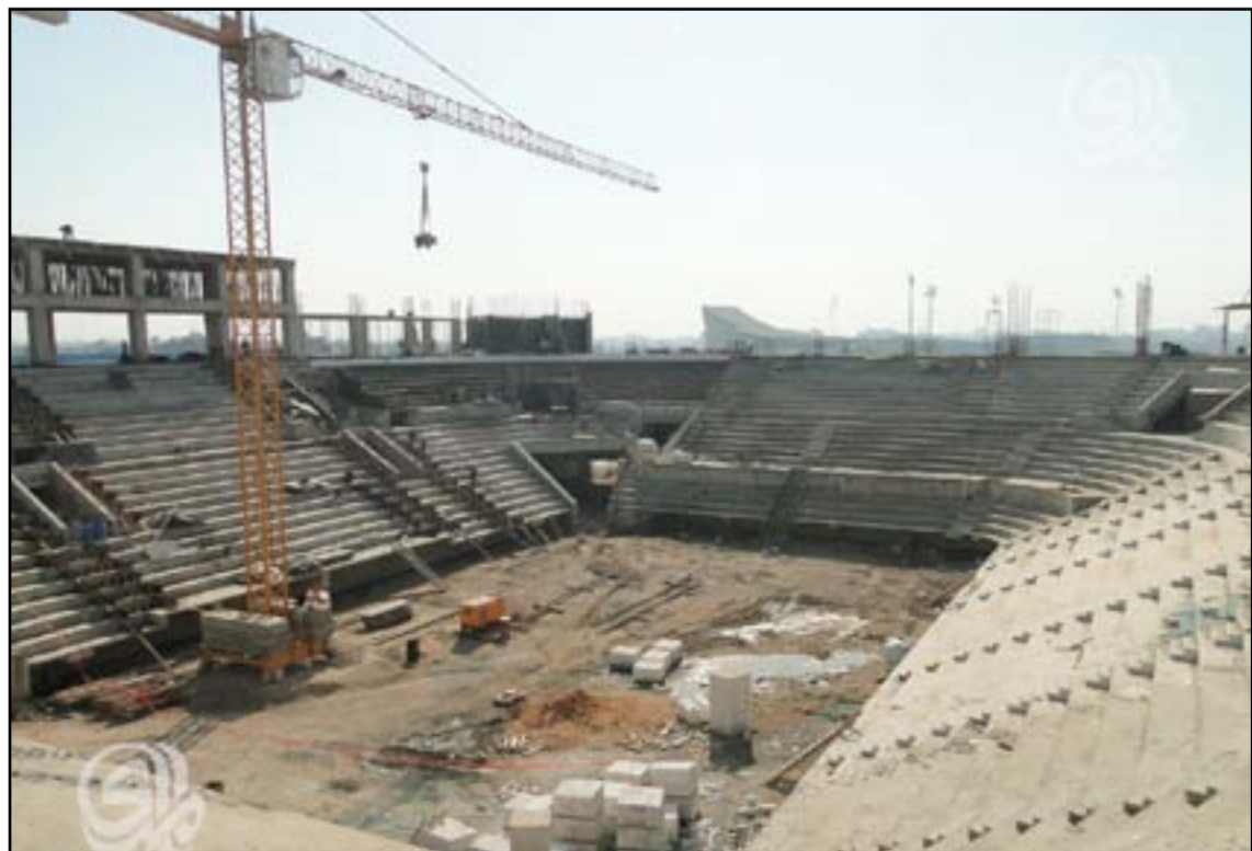
مشروع القاعة الرياضية شرقي بغداد الذي يتم انشاؤه من قبل شركة تركية.. ارضيف
