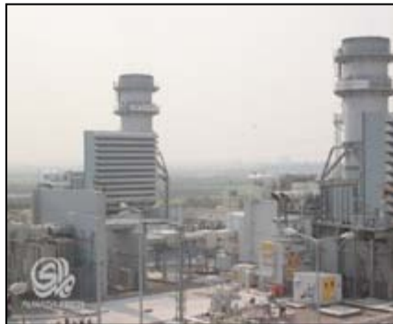
محطة كهرباء القدس الحرارية شمال بغداد
