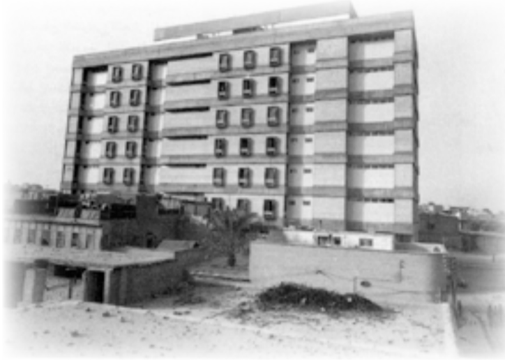
مبنى التبوغ، شارع الجمهورية (الستك)، بغداد (1961)، المعمار: رفعة الجادرجي، الواجهة الخلفية.
