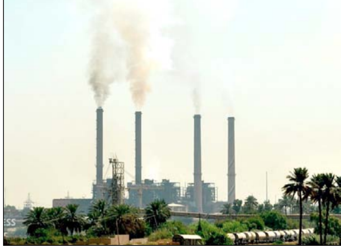
محطة كهرباء الدورة جنوبي بغداد تصوير (محمود رؤوف)
