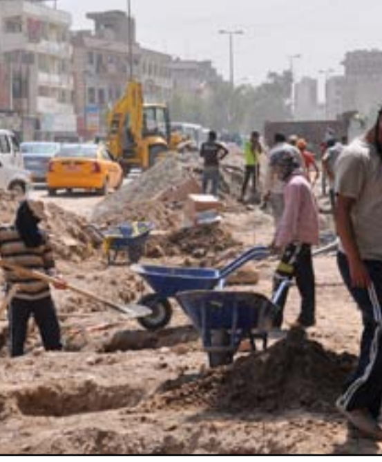
أعمال التأهيل التي لم توتي ثمارها
