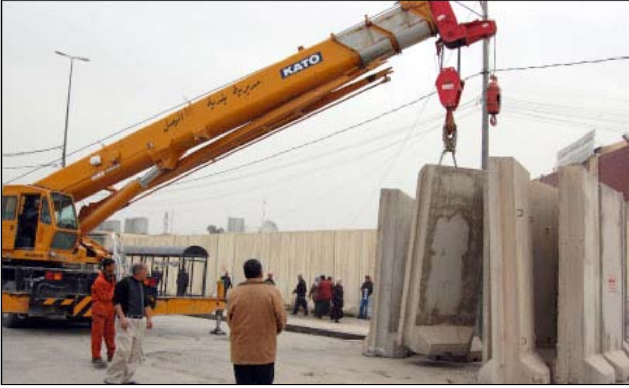
عمليات ازالة الصبات الكونكريتية من احد شوارع بغداد
