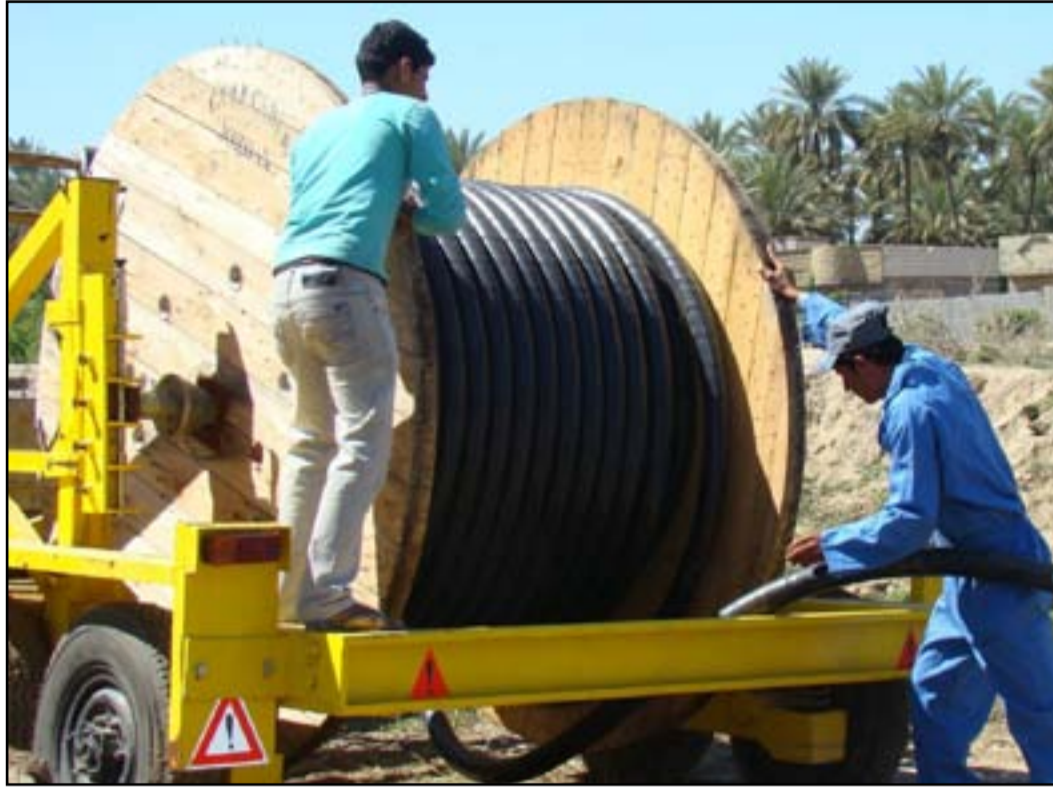
عمال صيانة الكهرباء، اثناء العمل.. وكالات
