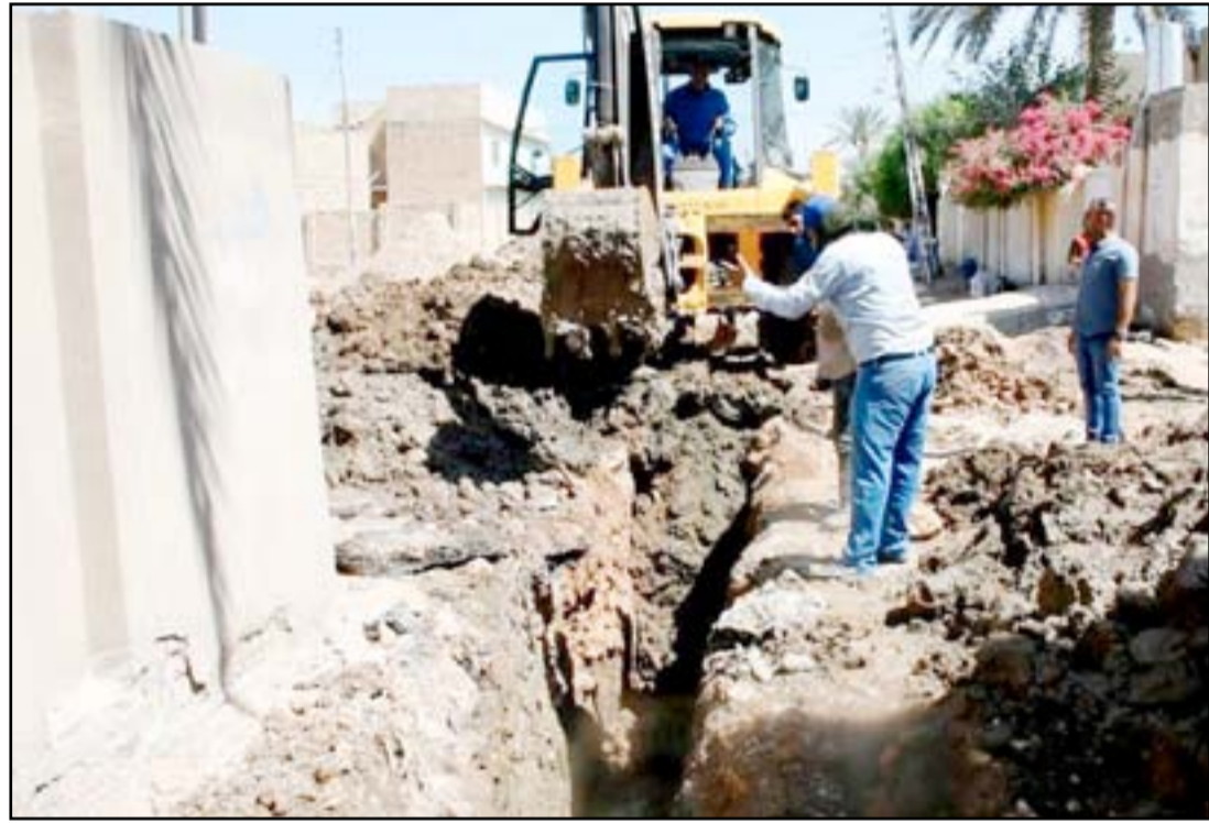
مشاريع ترميم مجاري بابل.. أرشيف
