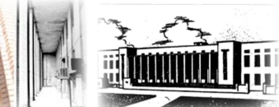
مبنى كلية الهندسة (1936)
