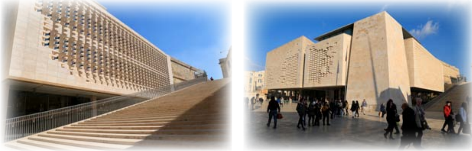
مبنى "برلمان مالطا" (2009 - 2015)، فاليتا، المعمار: رينزو بيانو، منظر عام.
