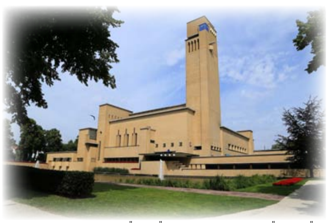
مبنى "بلدية هيلفرسوم" (١٩٢٤ - ١٩٣١)، هيلفرسوم/ هولندا، المعمار: "وليم دودوك"، منظر عام.
