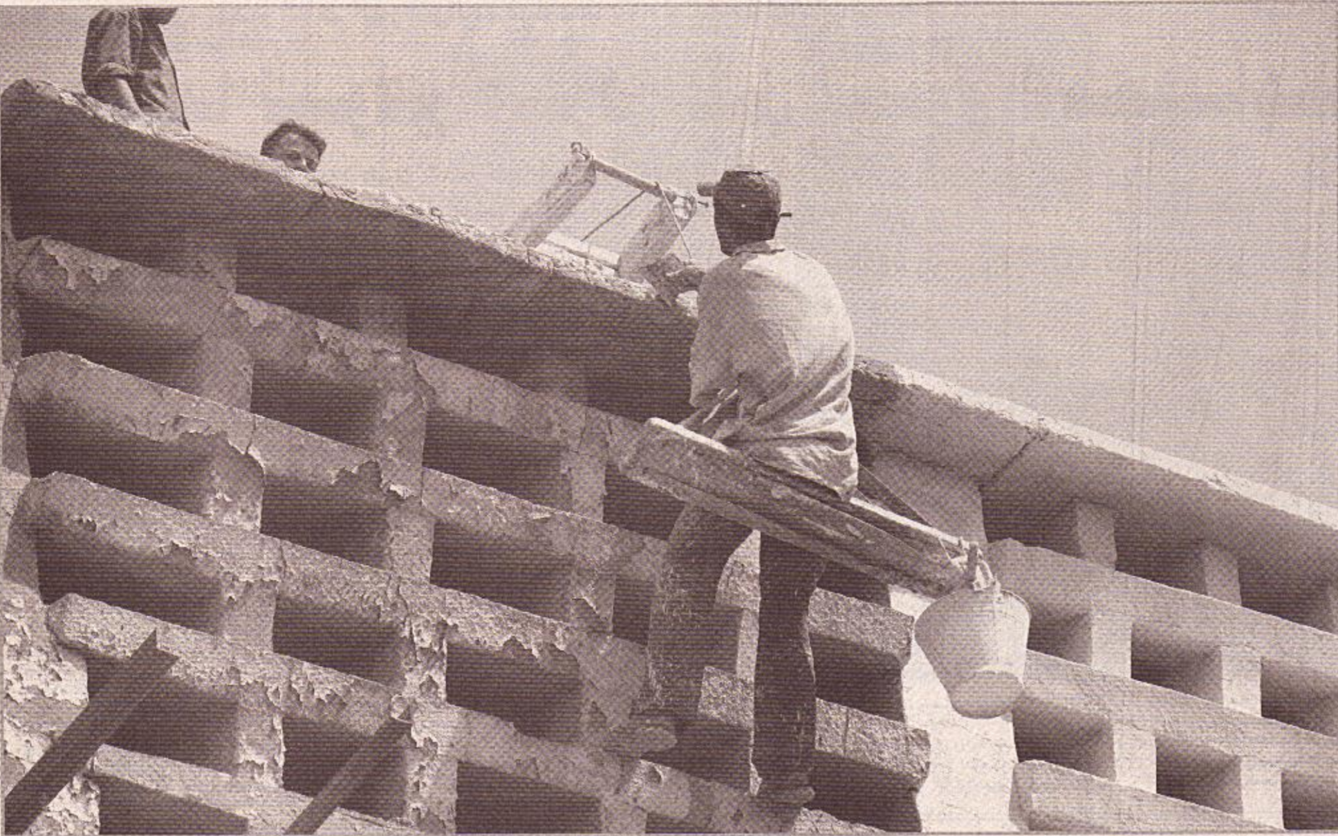
أعمال ترميم في البصرة
