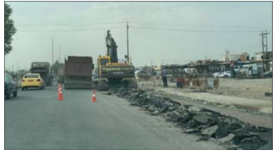
جانب من أعمال الصيانة في شوارع الموصل
