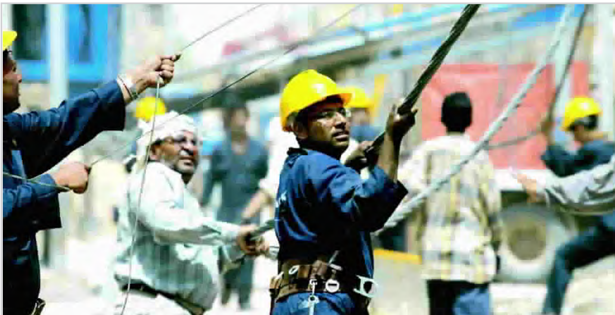
عمال عراقيون ينصبون اعمدة لشبكة الكهرباء في بغداد
