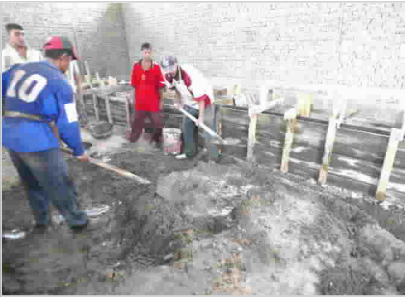
عمال بناء في موقع
