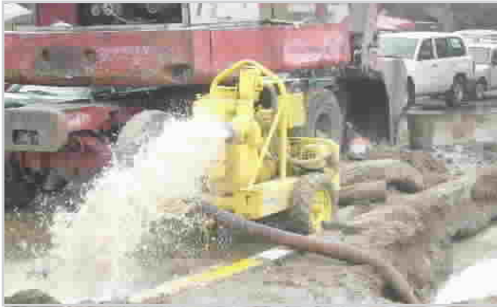
من أعمال الصيانة في شوارع بغداد
