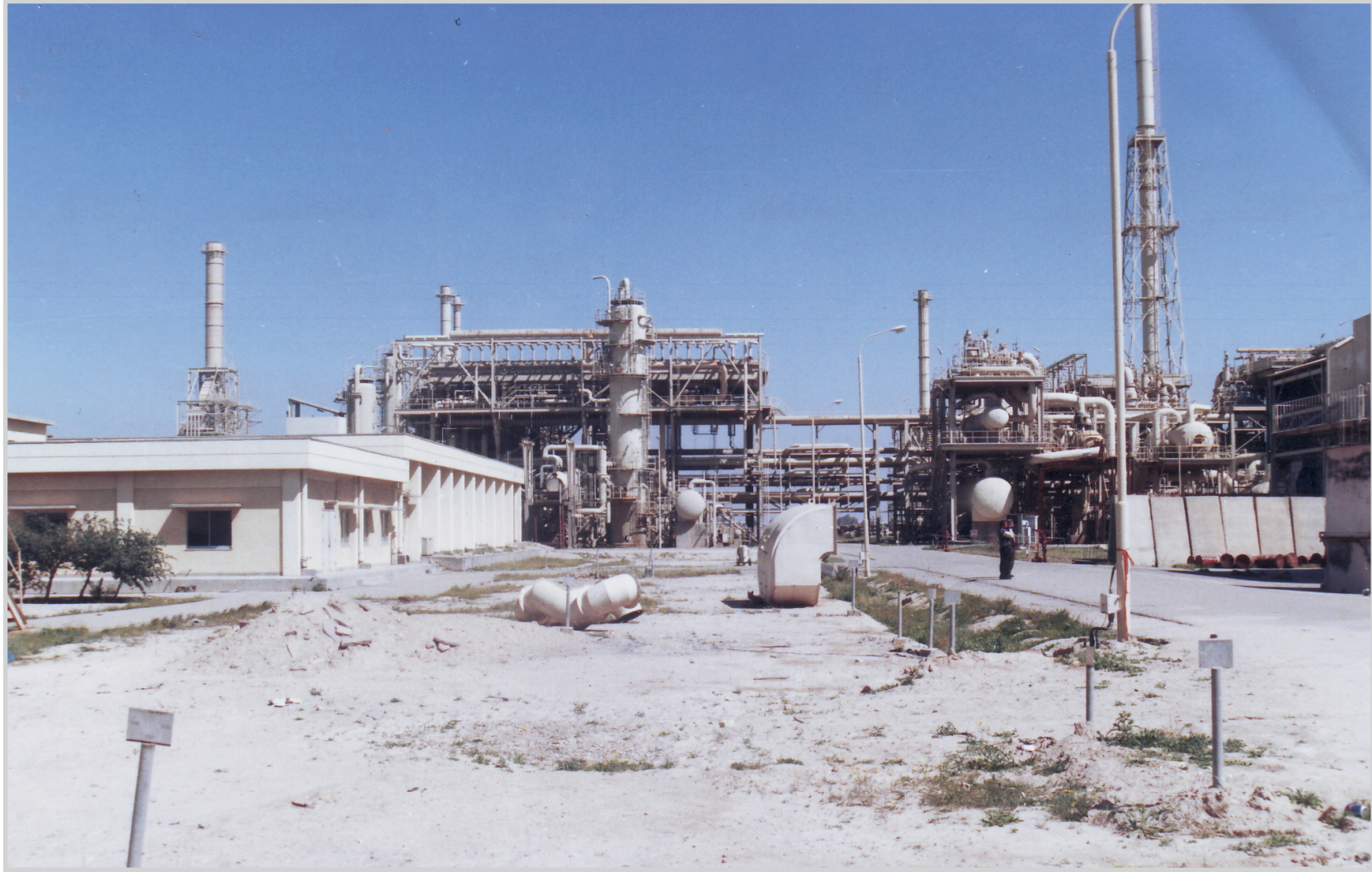
محطة توليد كهرباء غازية
