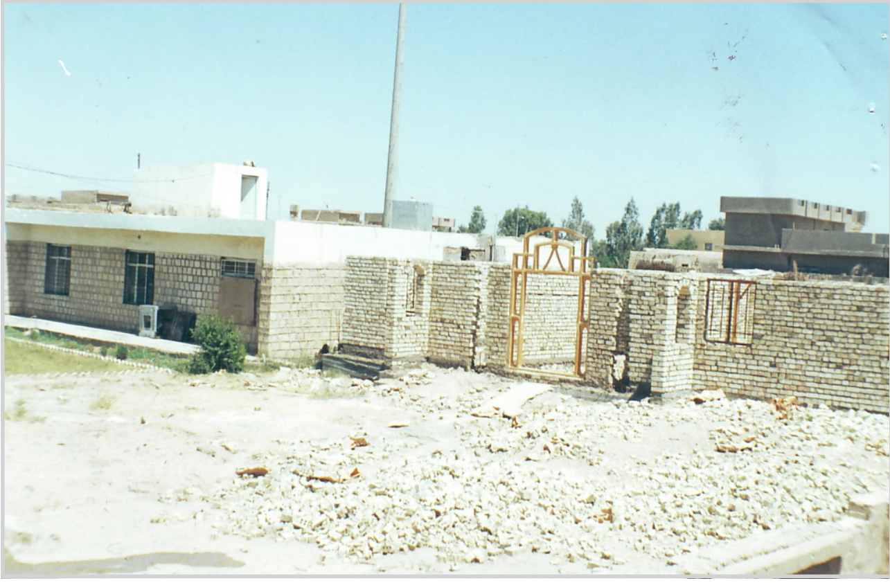
قطع اراضي تحت الانشاء
